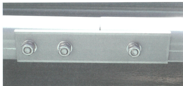
【図 1】従来の部材接合状況
