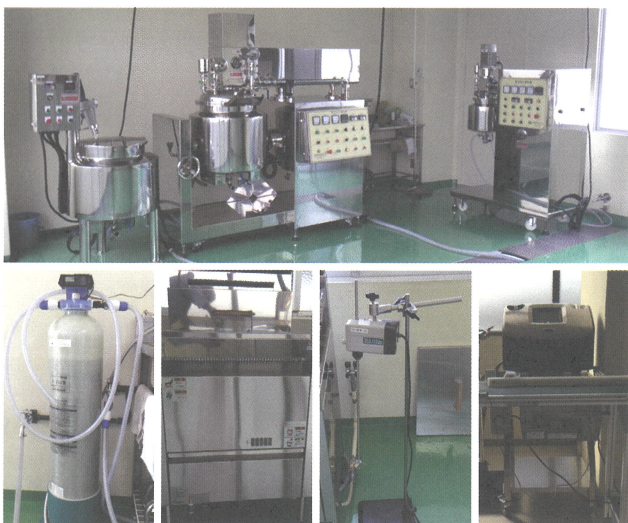
▲真空乳化装置・周辺機器設置
