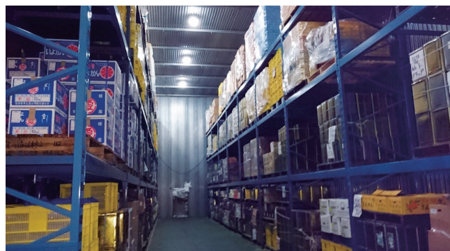
高機能冷凍システムを導入した低温倉庫内
