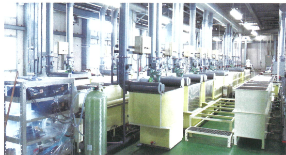
熱風循環乾燥器、純水製造器めっき用PP水槽などを組み込んだめっきライン
