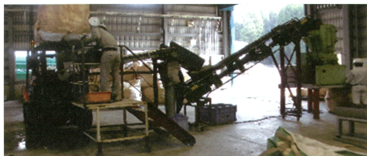
アルミ破碎設備
