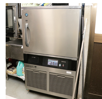
急速に食材を冷凍できるブラストチラー
