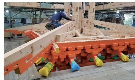
五重塔組み上げの様子
