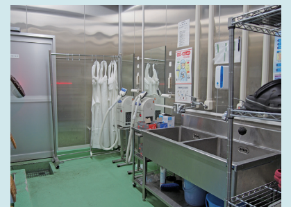
当社工場クリーンルーム
