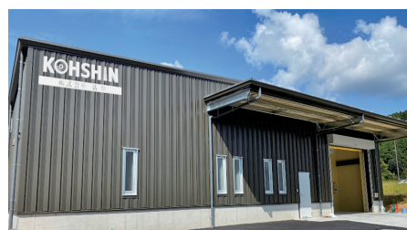
園部工場（京都新光悦村）燃糸・加工工場
