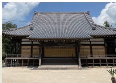
石原建築が施工した山口県の景好寺本堂
