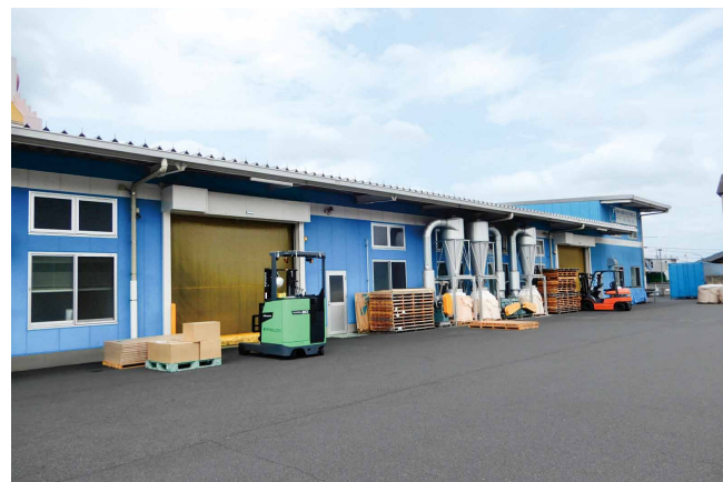
2017年に移転稼働した本社工場
