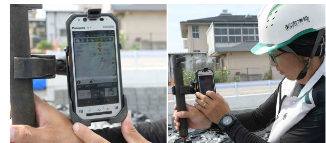
端末から位置出し・丁張設置・施工段階のチェックを行う
