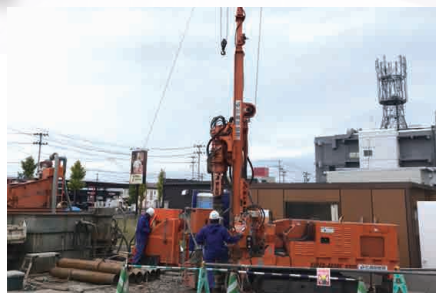
ボーリングマシン
