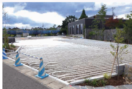
融雪工事の様子
