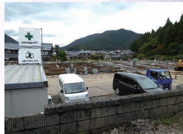
本社隣接地に新工場を新設中
