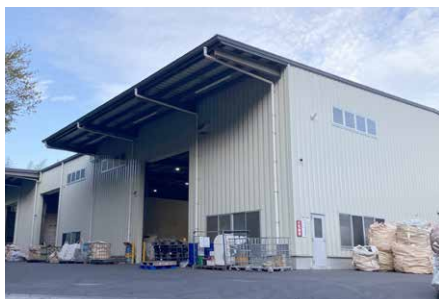
東日本マテリアルセンター
