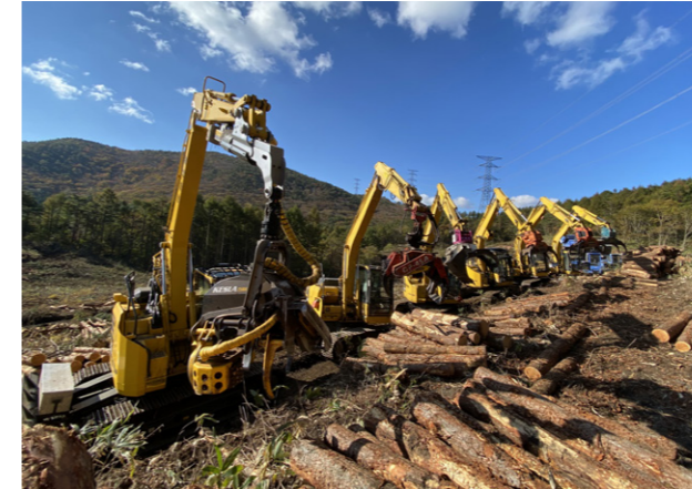
用途に応じた多様なアタッチメントを備えた重機群。カラマツ伐採にも対応できる柔軟な設備構成が強み
