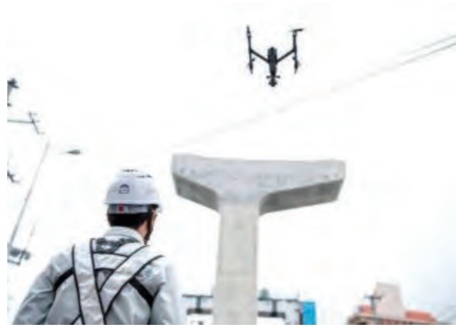
ゆいモレール延伸工事でのドローンによる測量 (HPより)
