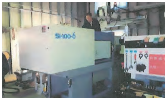
成形機の搬入作業（設置とトラバースの取り付け）
