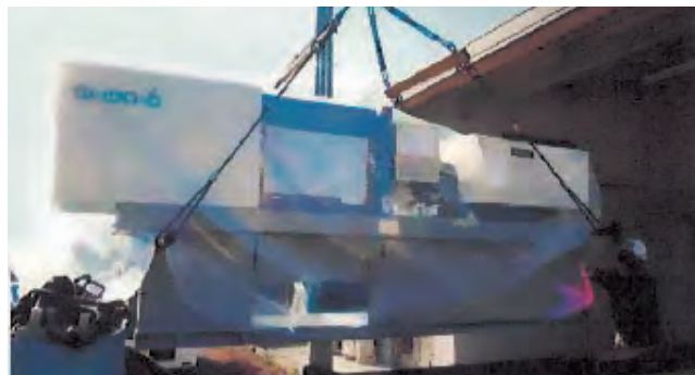
成形機の搬入作業（クレーンでのつり上げ）
