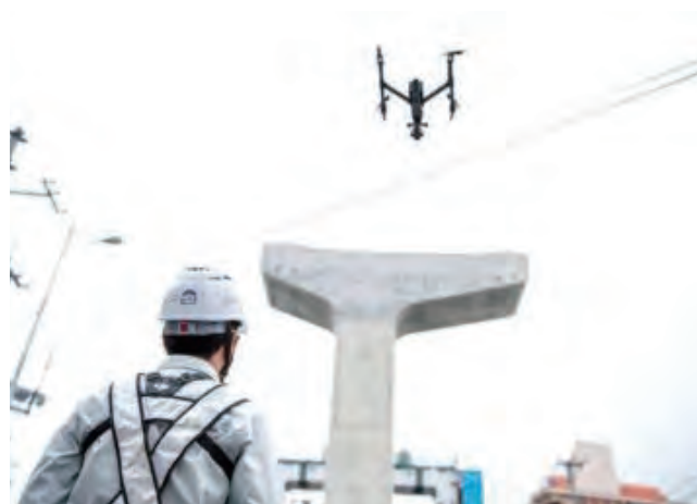
ゆいモノレール延伸工事でのドローンによる測量 (HPより)
